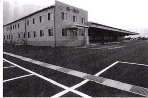
庄内支店の外観
